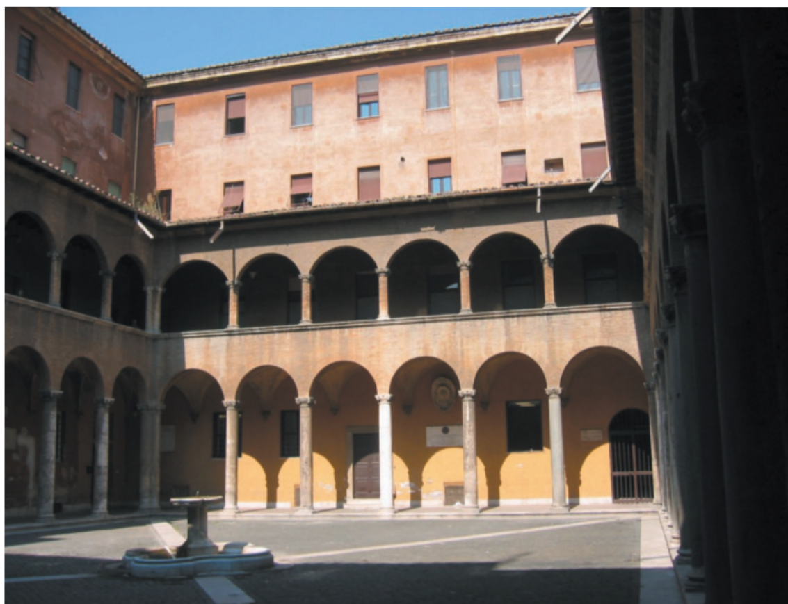
Figura 19 Il Chiostro dei Frati
